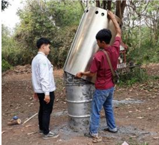
รูปที่ 5 การคาร์บอนไนซ์ด้วยเตาที่สร้างขึ้น
